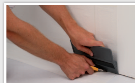
15 Araser au niveau des plinthes.
