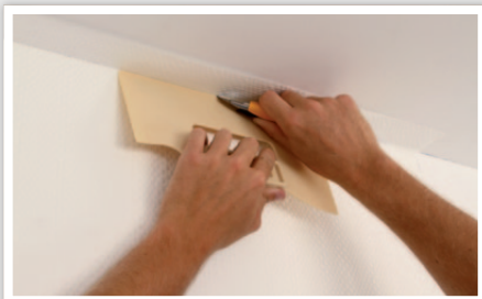
10 Araser* au plafond.
